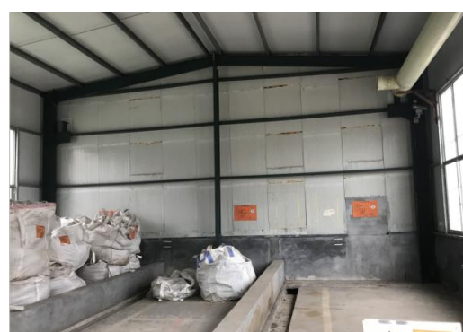
危废间贮存场
